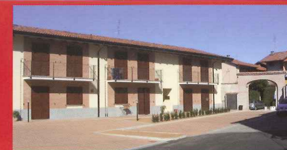
L'edificio che l'Edificatrice Uno ha ristrutturato nel centro storico di Gaglianico
